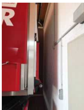
Bild 3, Große Fahrzeughalle Embken
